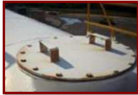
Figura 3. Proceso anticorrosivo para el área de combustibles
